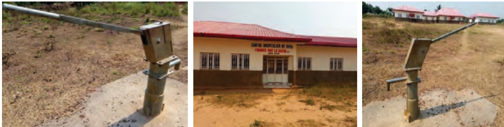
Photos de forage d'eau et un hôpital construit et non équipé
